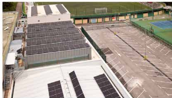
Instalaciones fotovoltaicas en C.D. Amaya
