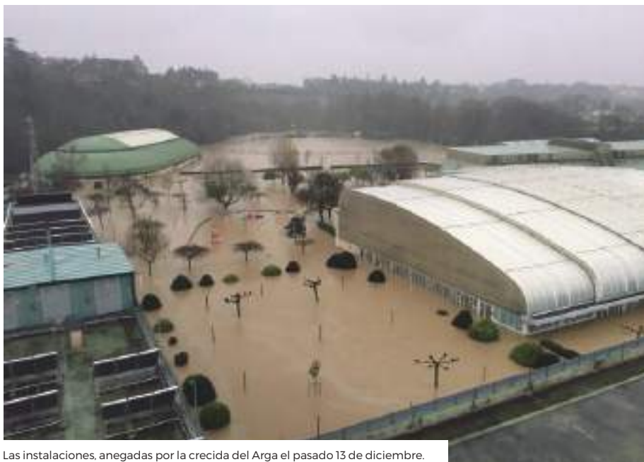
Las instalaciones, anegadas por la crecida del Arga el pasado 13 de diciembre.
